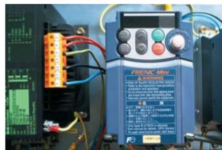
↑ Частотнорегулируемые электроприводы, позволяющие производить плавный пуск механизмов и регулирование скорости, существенно снижающие время мойки.
